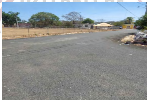
Ilustración 22 Supervisión de Obra Recursos Municipales 2023
