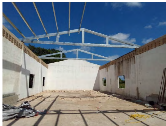
Ilustración 8 Supervisión de Obra FAISMUN
