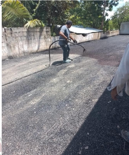
Ilustración 17 Supervisión de Obra FORTAMUN 2023
