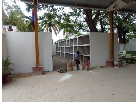
Ilustración 20 Supervisión de Obra FOPET 2023
