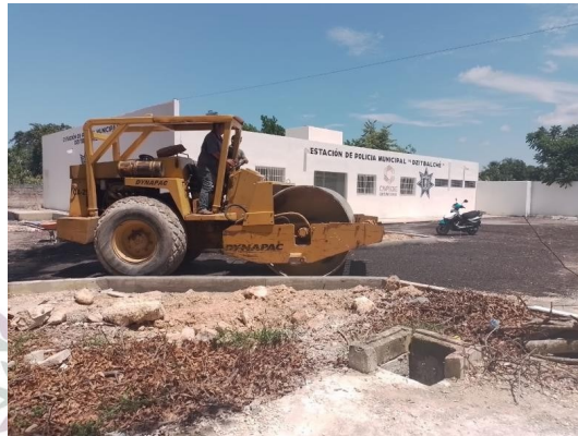
Ilustración 15 Supervisión de Obra FORTAMUN 2023
