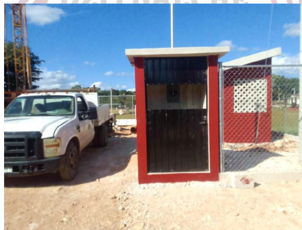
Ilustración 14 Supervisión de Obra FISE 2023
