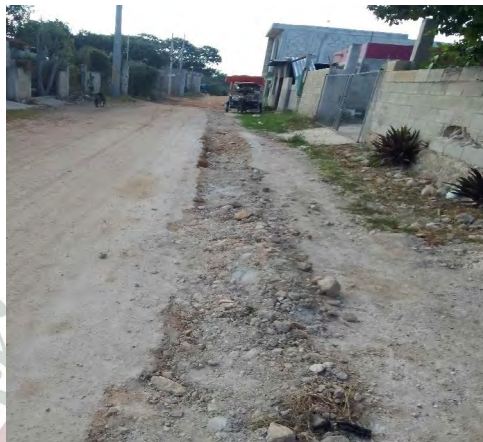
Ilustración 11 Supervisión de Obra FISE 2021-2024 Un Gobierno del pueblo
