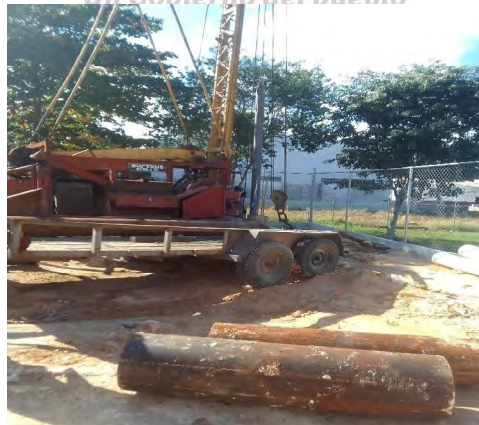
Ilustración 12 Supervisión de Obra FISE
