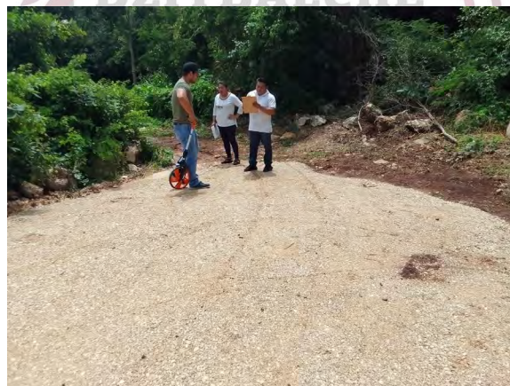
Ilustración 10 Supervisión de Obra FAISMUN
