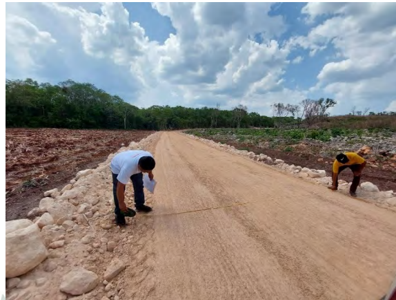
Ilustración 9 Supervisión de Obra FAISMUN
