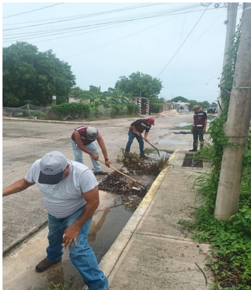
Limpeza de alcantarillas como una de las medidas de prevención por inundación.
